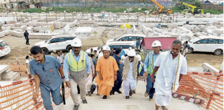
అయోధ్యలో రామమందిర నిర్మాణం పనులను శనివారం పరిశీలిస్తున్న యుపి సిఎం యోగి ఆదిత్యనాథ్
